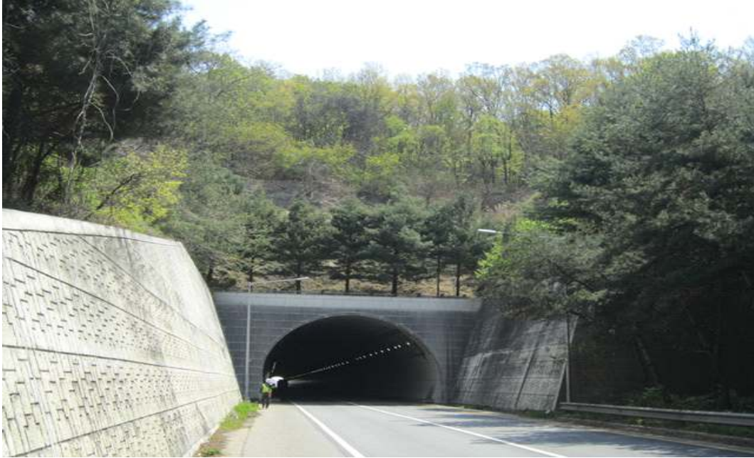
오천터널(상행선) 외부 전경
